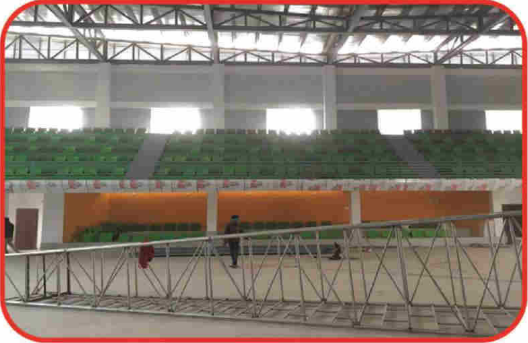
মুন্সিগঞ্জ জেলাস্থ নির্মাণাধীন ইনডোর স্টেডিয়াম চলমান গ্যালারীসহ সেড এর কাজ
